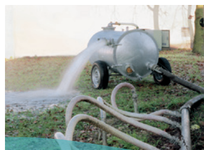
Gruntinio vandens žėminimas
