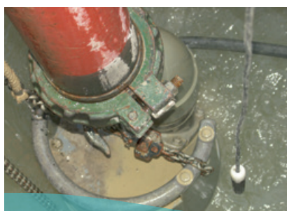
Siurblių montavimas aikštelėje
