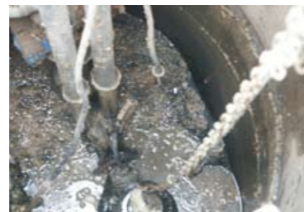
3 pav. „Šlapiai“ montuojami panardinami siurbliai (Šaltinis: dipl. inž. J. Mading, Vokietija)
