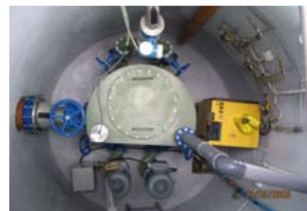
4 pav. Nuotekų talpykla ir „sausai“ montuojami siurbliai siurblineje (Objektas: Insbud Rybnik, Lenkija)
