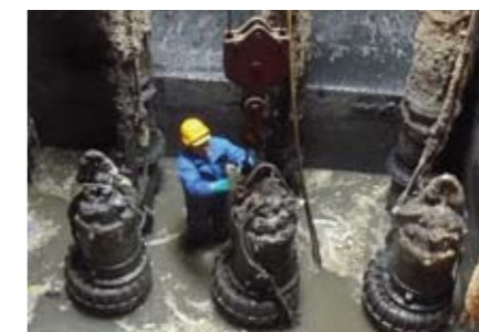
9 pav. „Šlapiai“ sumontuoti siurbliai techninis aptarnavimas eksploatavimo vietoje (šaltinis: „Scottish Water“)
